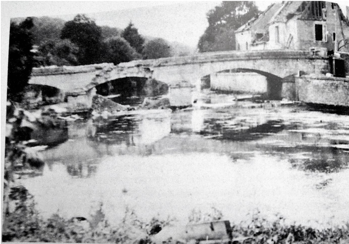
Pont Saint-Jean détruit à Châteaudun.
